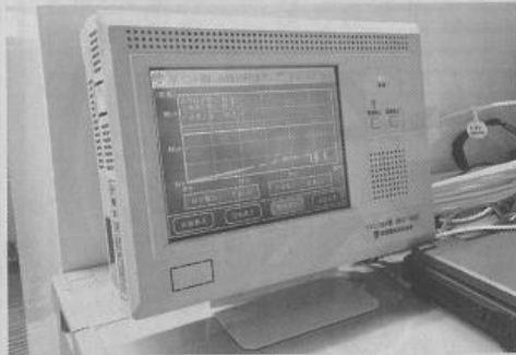
電気の使用量が設定値に近づくと警報音で知らせる（京葉銀新船橋支店）
